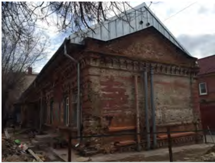
начало реставрации ЛОФТ1890
