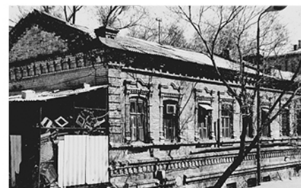
Состояние здания до реставрации (1987 г.)
