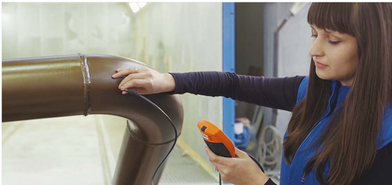
Инструментальный контроль качества покраски
