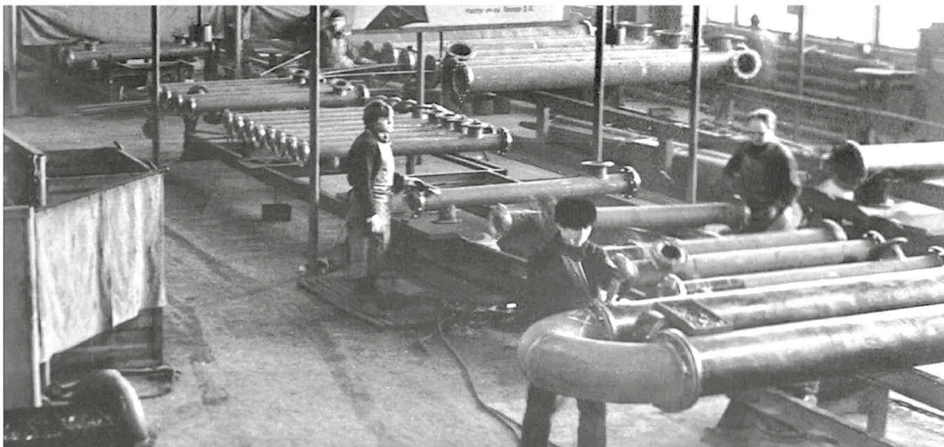
Цех по производству теплообменников волгоградского завода монтажных заготовок треста «Южсантехмонтаж». Проезд Крутой, 3
