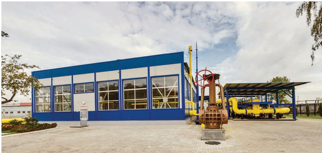
ГРП «Южная ГС», ОАО «Мосгаз» [г. Москва]
