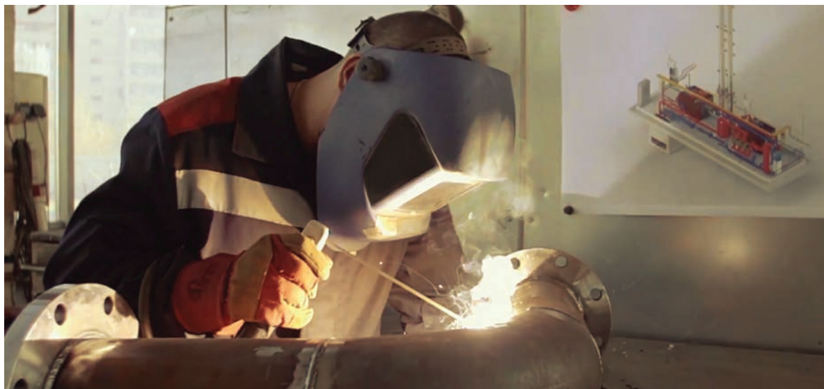
Сварка трубопроводного узла АБМК в ЦМЗ МУ ООО «Итгаз»
