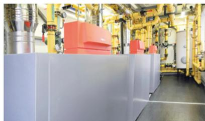
Техническая уникальность данной АБМК состоит в том, что наше предприятие получило опыт в проектировании, монтаже и изготовлении блочно-модульной котельной с применением трёх низкотемпературных газовых водогрейных котлов «Viessmann» модели VITOGAS 100-F.
